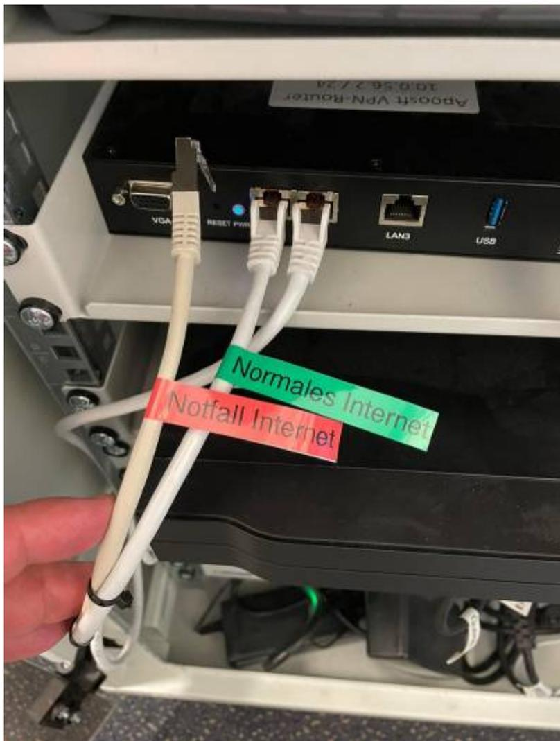
Es empfiehlt sich, die LAN-Kabel des aktuellen Routers und des LTE-Routers mit Kabelbindern aneinander zu binden. Im Notfall ist dadurch einfach ersichtlich, welches Kabel gezogen und welches neu eingesteckt werden soll.
